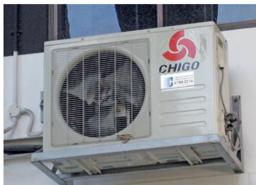
■ Figura 1.14 Un aparato de aire acondicionado de uso doméstico
